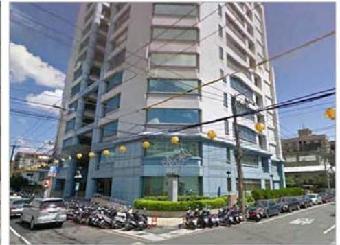
3.更新單元北側建物
