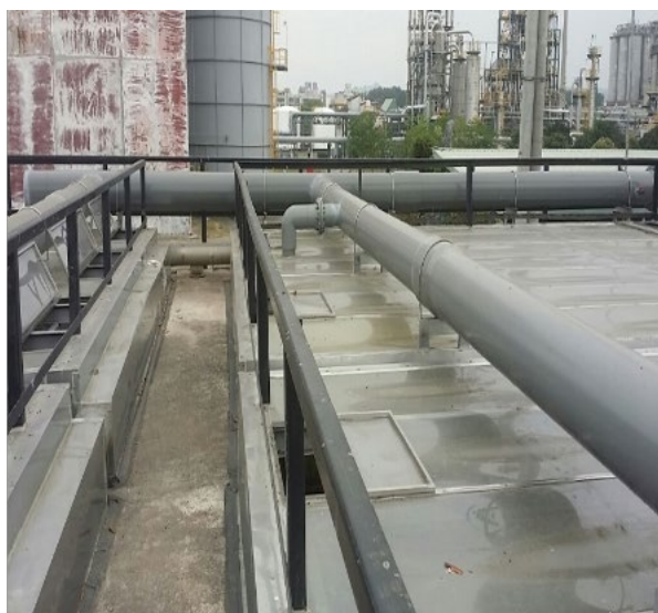
廢水池全面加蓋工程
