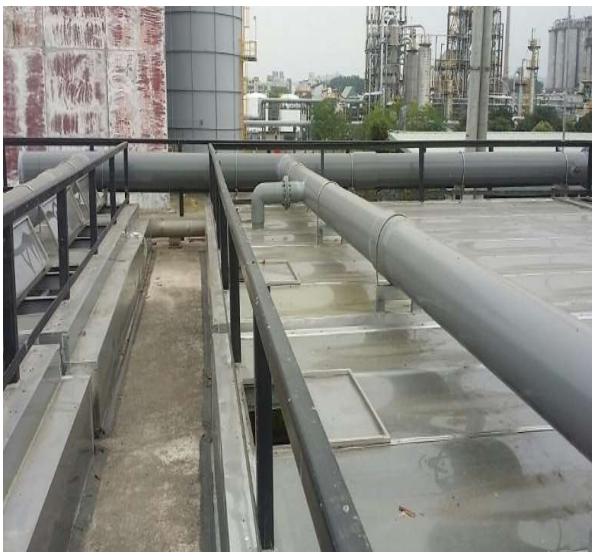
廢水池全面加蓋工程
