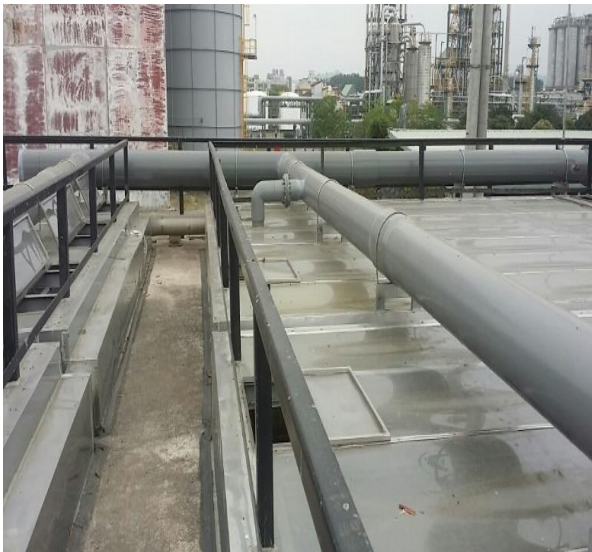
廢水池全面加蓋工程
